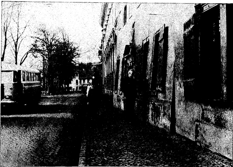
Abb. 4. Durch Setzungen in den holozänen Aueablagerungen hervorgerufene Neigung eines Wohnhauses. Weißenfels, Maxim-Gorki-Promenade
