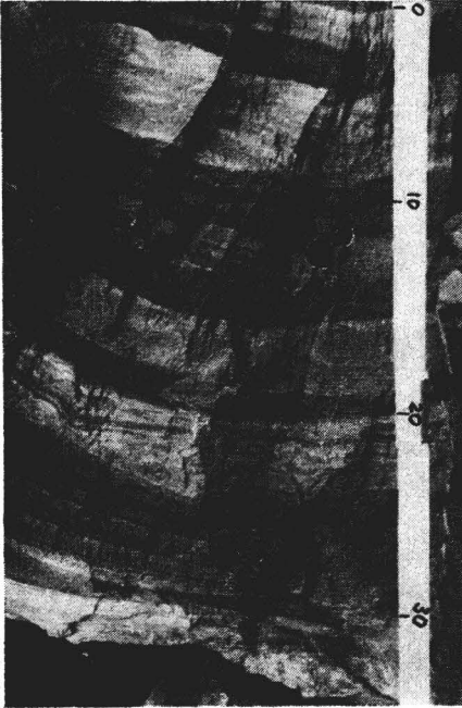
Abb. 3 Rechtwinkliger Anschnitt zu Gruppe B, Abb. 1, durch Sprengschuß entstanden. Die latente, steilstehende Schieferung wird an den Bruchkanten deutlich
