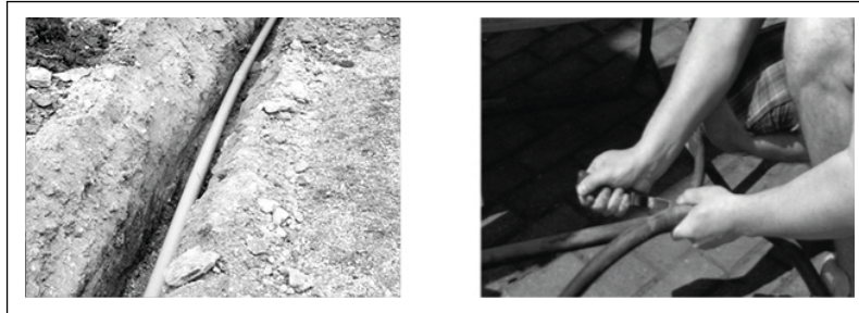
Abbildung 11. Praktische Umsetzung. Links: Ausgehobener Erdgraben und Verlegung eines Niederspannungskabels im Leerrohr. Rechts: Abisolieren des Erdkabels im Rahmen der Verlegung des Niederspannungskabels.
