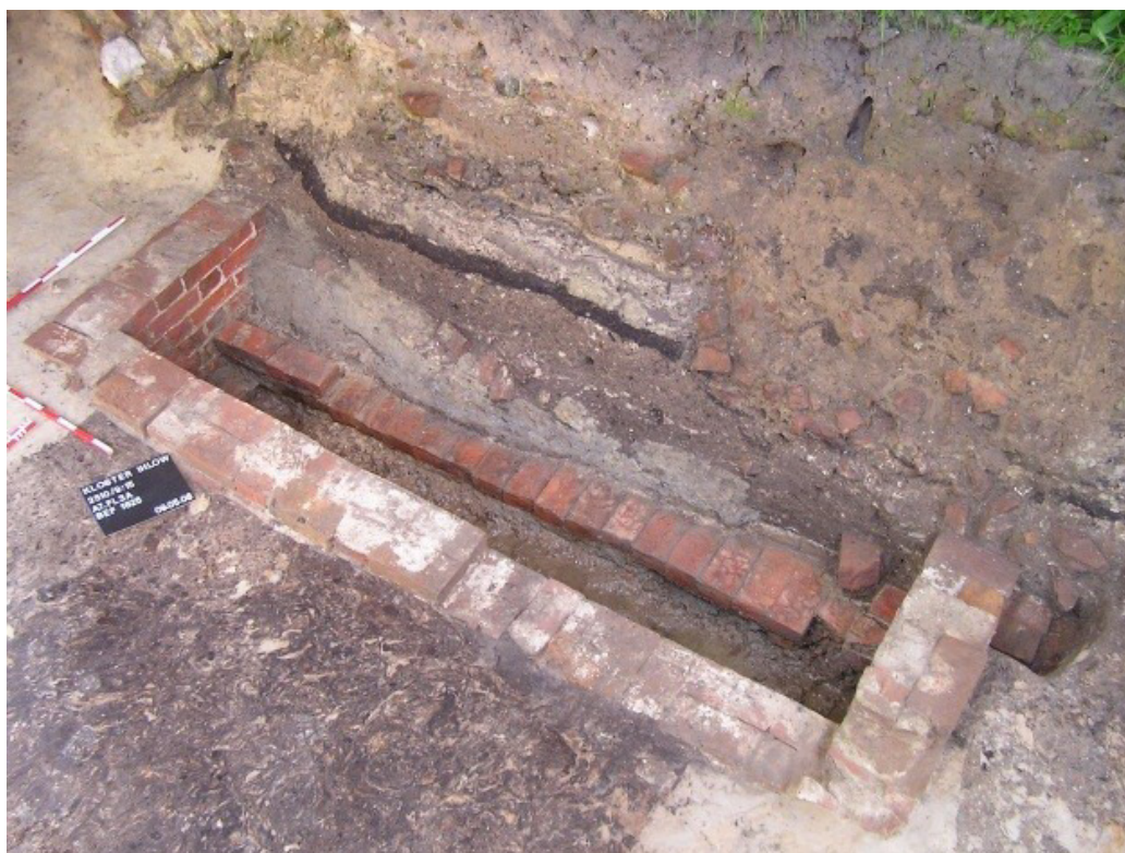
Abbildung 45: Die angeschnittene Heizanlage.
