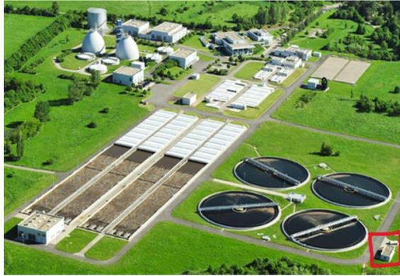
Abb. 8: Übersicht der Kläranlage Halle-Nord (vor 2017) mit der Ablaufmessstation am Ende der Abwasser-reinigung (rot eingerahmt). [22]
