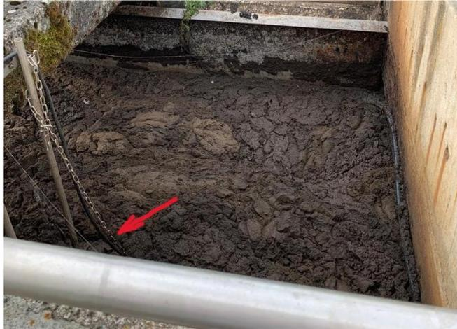
Abb. 25: Probenahmestelle der Gebläsemessstation mit übermäßig viel Schlamm (roter Pfeil markiert die Position der Pumpe).
