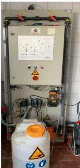
Abb. 4a: Ultrafiltrationsanlage in der Gebläsesmessstation.
