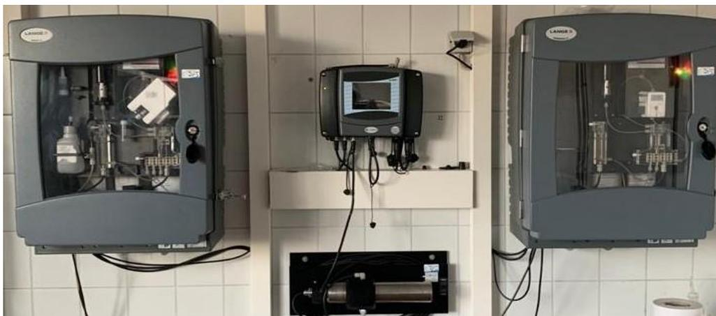
Abb. 5: Analyatoreinheiten und Displaymodul in der Gebläsesmessstation.
