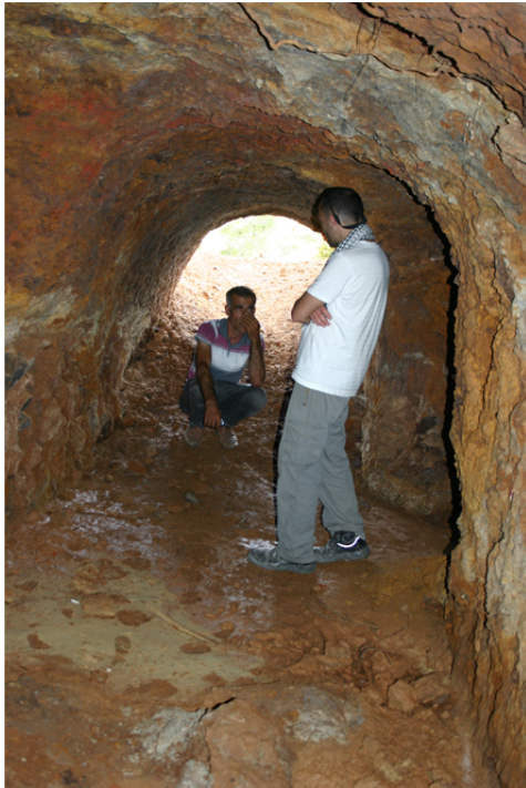
Abb. 14.1.22: Stollenmundloch im Kalkstein und die Dimension des Stollenausbaus.
