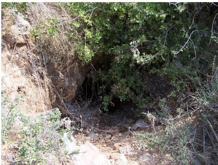
Abb. 14.1.20: Halb verschüttetes Stollenmundloch (1,20 m breit und 90 cm hoch) an der nördlichen Flanke eines Taleinschnittes bei Gümüldür.
