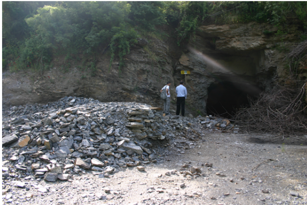
Abb. 14.1.4: Stollenmundloch bei Palamut Dere mit einer vorgelagerten Halde.
