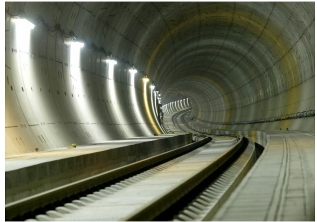
(b) S-Bahn-Tunnel in München (aus [HK12] entnommen)
