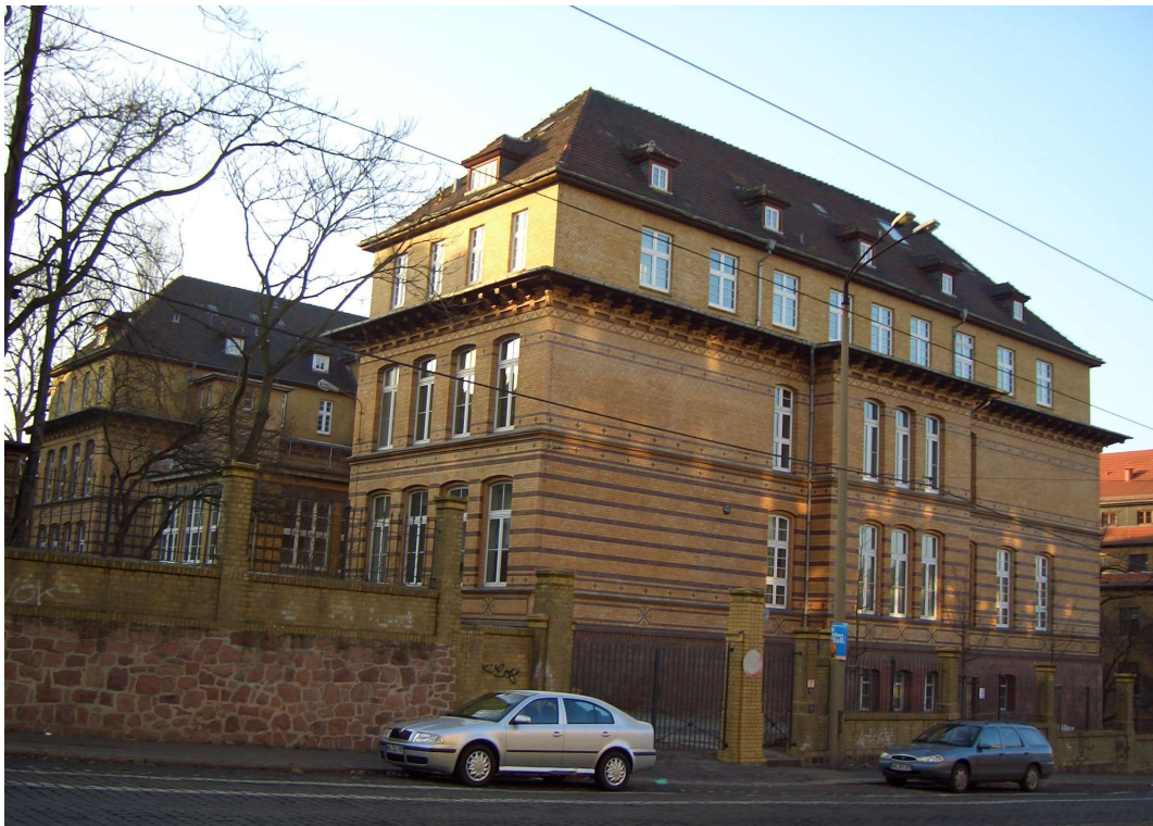
Abb. 13: ehemalige Universitäts-Augenklinik an der Magdeburger Straße in Halle
