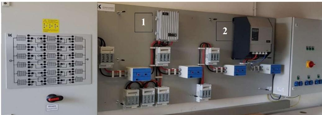
Abbildung 19: Laderegler und Wechselrichter TZK [36]
