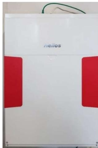
Abbildung 24: Kreuzgegenstromwärmetauscher TZK [36]
