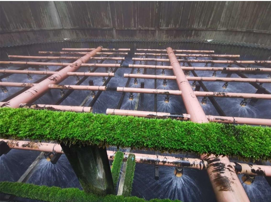
Abbildung 12: Die Wasserversprüher im inneren Raum des KT [Z. Alhilar, 2020].
