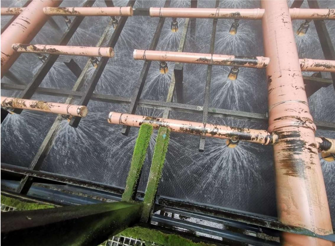
Abbildung 13: Die Wasserversprüher im inneren Raum des KT [Z. Alhilar, 2020].
