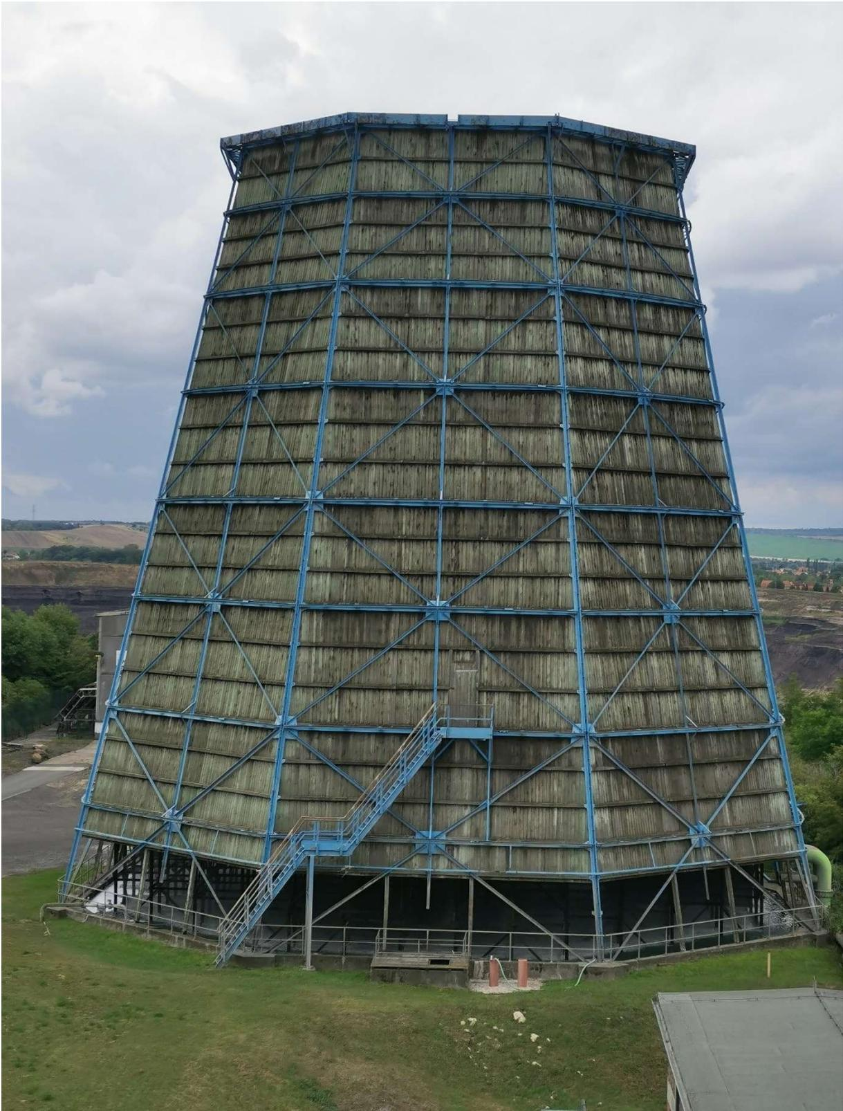
Abbildung 11: Naturzugkühlturm 3 (ohne Ventilator) bei ROMONTA GmbH, [Z. Alhilar, 2020].
