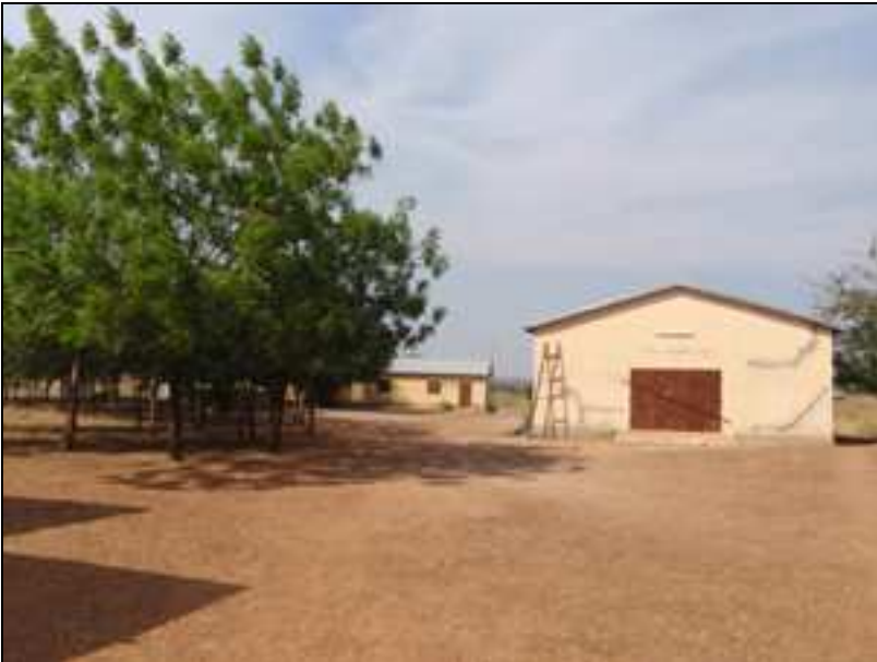
Foto 20: Gebäude der CAP Kpong (November 2008)
