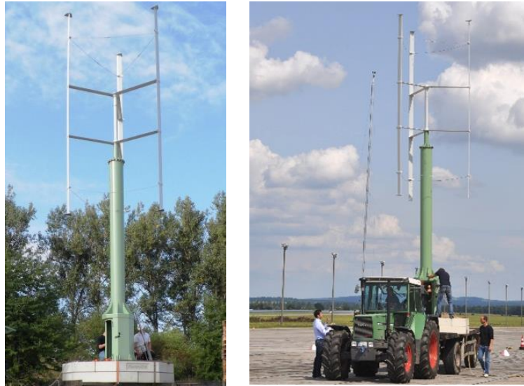
Abbildung 34: Mill-4-all-Windkraftanlage und Anlage auf Trägerfahrzeug
