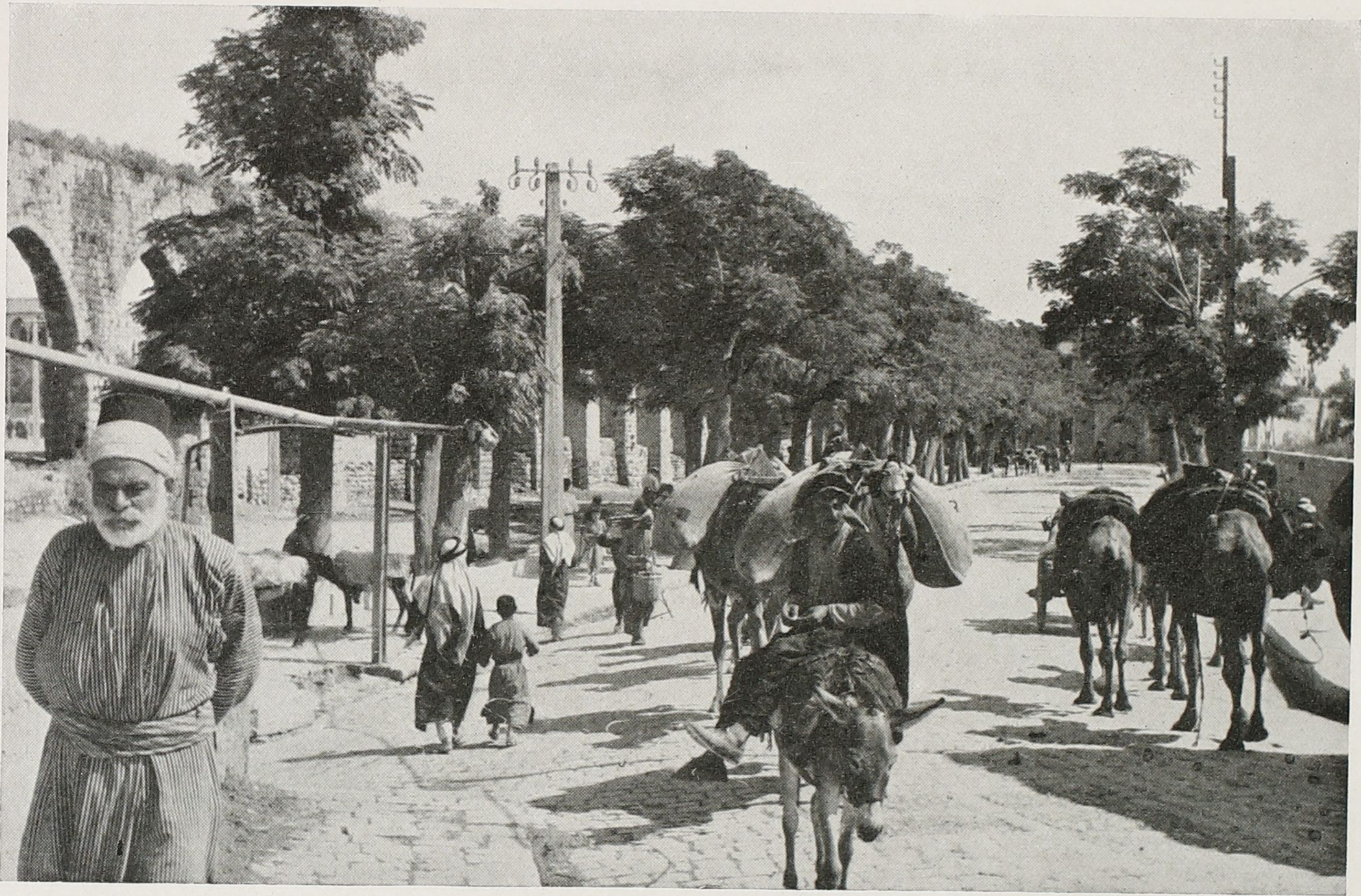
65. Hama, Straße nach Homs nahe der Asis (Orontes) Brücke. Links antike Wasserleitung auf hohen Bogen. (Zu Seite 64, 97, 102.)
