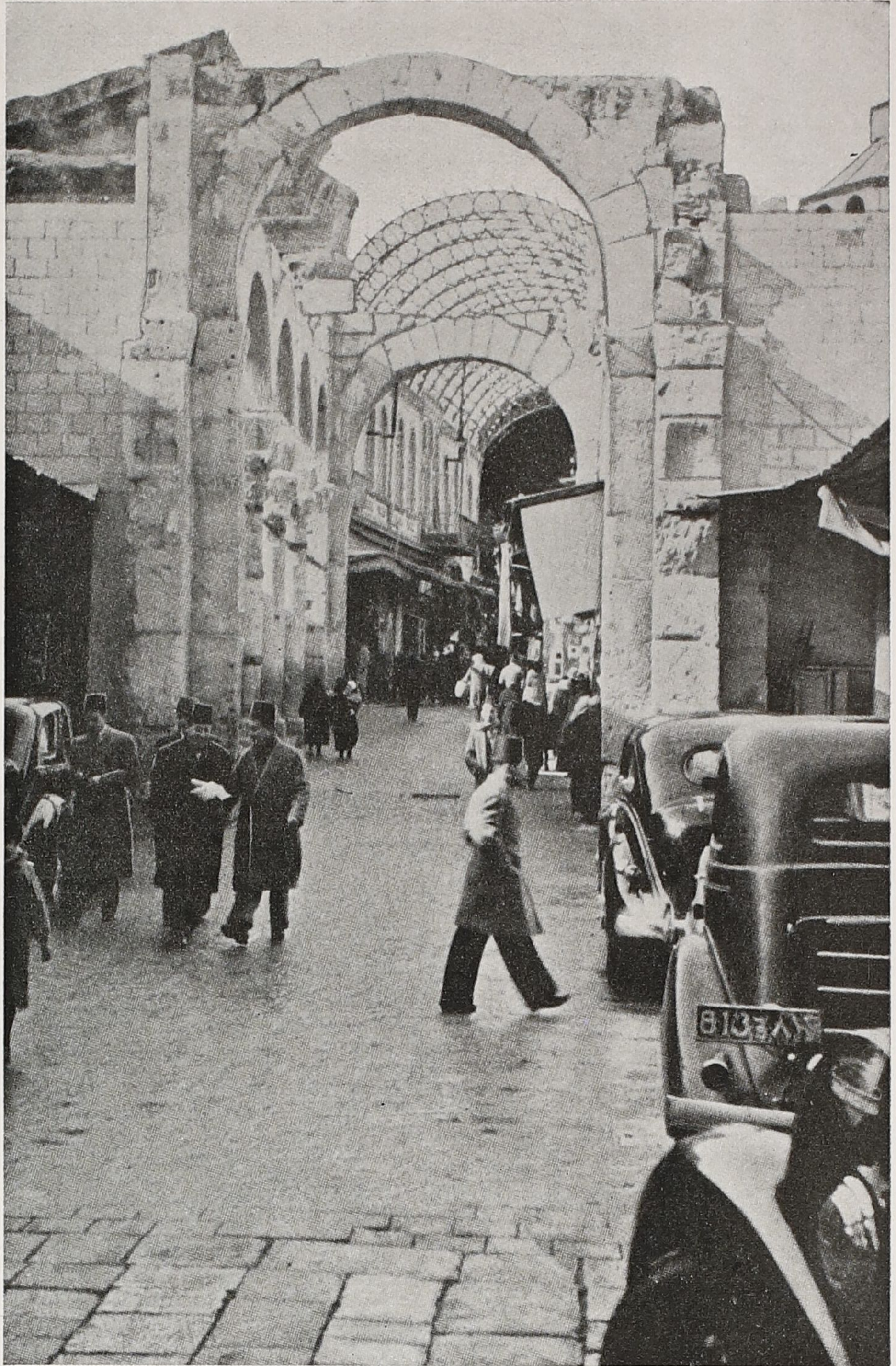
72. Soukh (Bazar) in Damascus, eingebaut in antike Ruinen.
