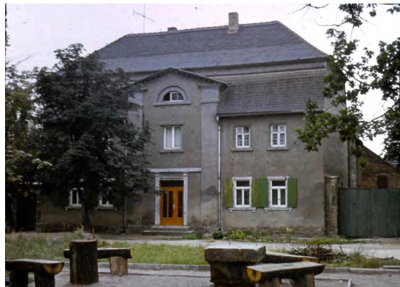
↑ 1977. Wohnhaus Nr. 16 nach Renovierung ohne Gaupen. (Thorsten Fielon #6.25)
