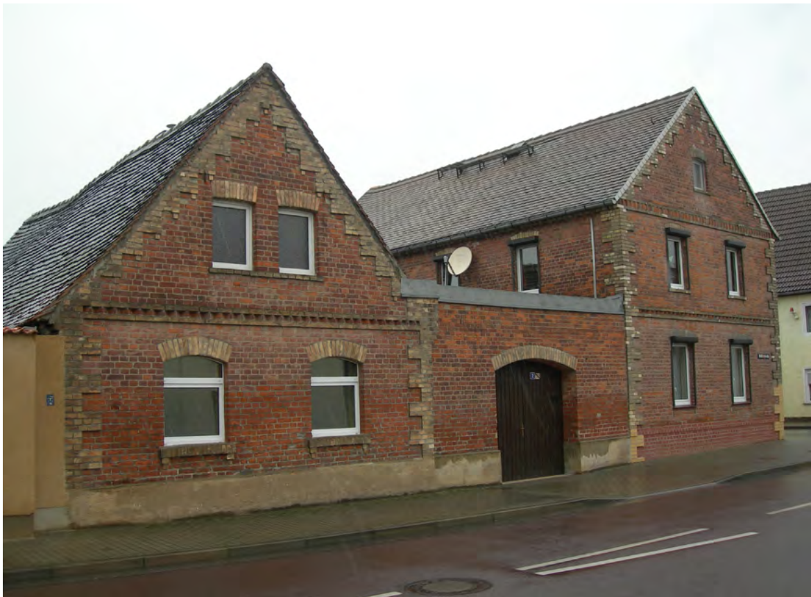
Gebäude der ehemaligen Schmiede Bastanier. (Andreas Becker #5.04)
