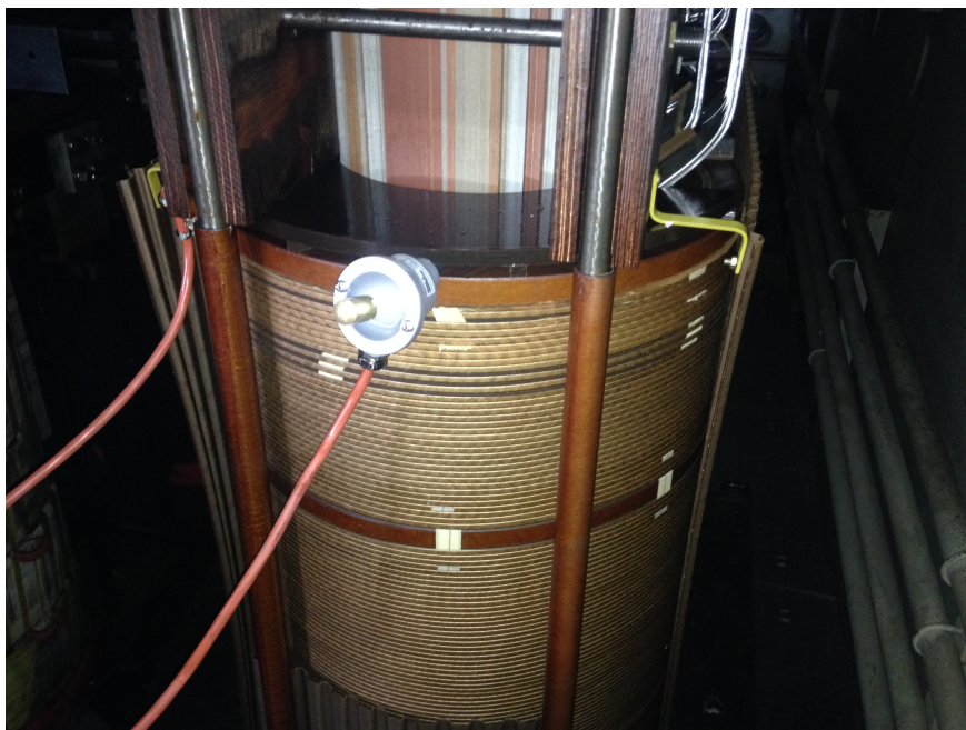
Abbildung 4.4: PT-100 Temperaturmesswiderstand in der Papierisolierung während der Trocknung
