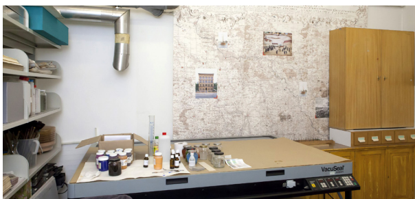
Wo jahrelang die stillgelegte Begasungsanlage stand, kann jetzt wieder gearbeitet werden
