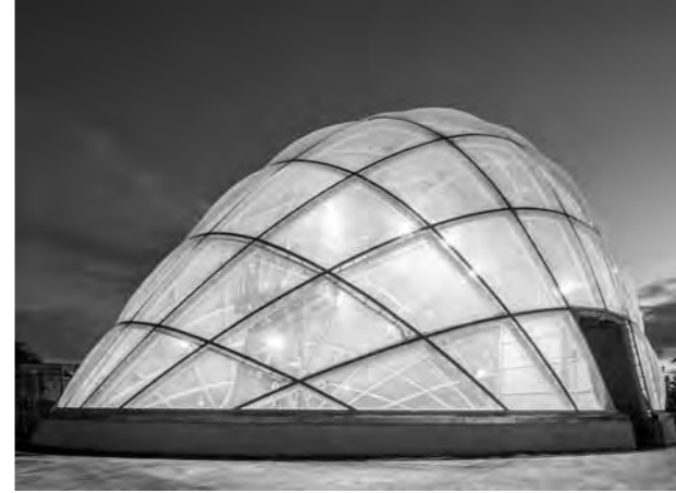
Gewächshaus im Botanischen Garten, Aarhus Kissenoberfläche: 1.800 m 2 Grundfläche: 1.145 m 2 Bogenhöhen bis zu 17,5 m Bogenspannweiten bis zu 41 m ETFE-Folie in 200–150–250 µm Anzahl Kissen: 88 fest stehende zweilagige Kissen, zwei öffnere Firstkissen, 34 dreilagige Kissen mit pneumatischer Verschattung
