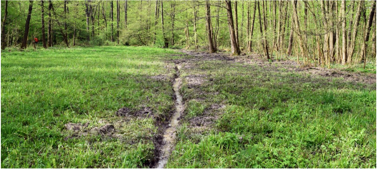
Abb. 24: In Handarbeit instandgesetzter Wiesengraben bei Wettelrode. Mit Unterstützung des Jugendwaldheims Wildenstall wurde der stark verkrautete Wiesengraben im April 2018 in der Dimension einer Spatenbreite und Spatentiefe ausgehoben.
