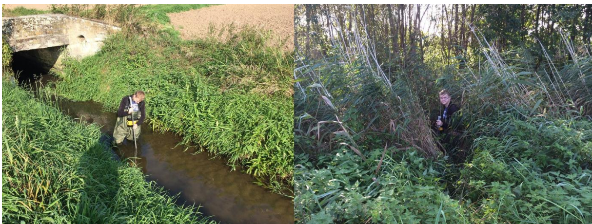
Abbildung 11: Messung oberhalb der Renaturierung (links) und im Renaturierungsgebiet (rechts) (03.10.2014) Die Fließgeschwindigkeitsmessung wurde oberhalb der R. (10m vor der Brücke),
