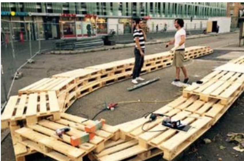
Abbildung 4 Bau der Sitzkonstruktion ((BBSR /BBR 2016)
