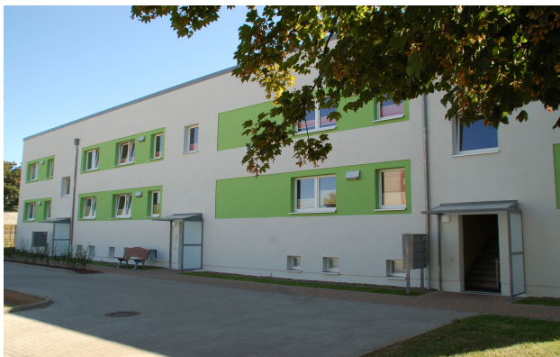
Frontansicht des Wohngebäudes (Wohnungsgenossenschaft Hettstedt e.G.)
