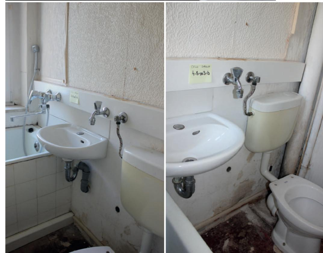
Fallrohre, Installationen und Elektroleitungen wurden weitgehend auf Putz verlegt und sind teilweise noch im Originalzustand. Die Sitzbadewanne ist im Originalzustand. Waschbecken sowie Stand-WC wurden zwischenzeitlich erneuert.
