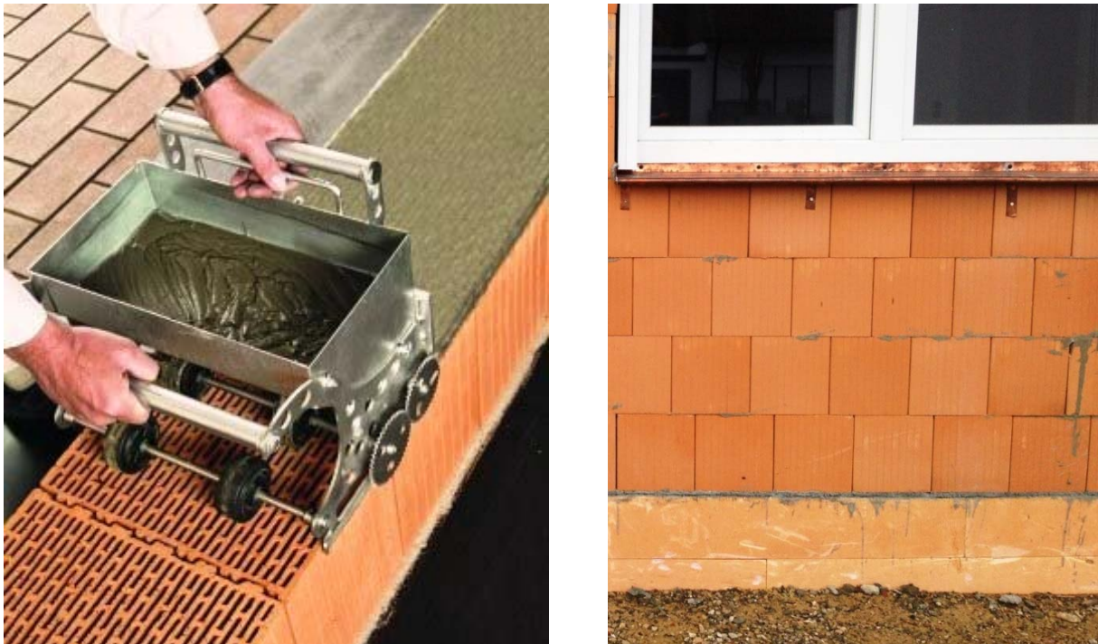
Bild 1: Aufbringen von Dünnbettmörtel auf eine Planziegel-Mauer mithilfe eines Mörtelschlittens (links) (© Franken Maxit Mauermörtel GmbH & Co., 2012); Vermauern von Planziegeln mit Dünnbettmörtel (rechts) (Archiv Schmidt, 2012)
