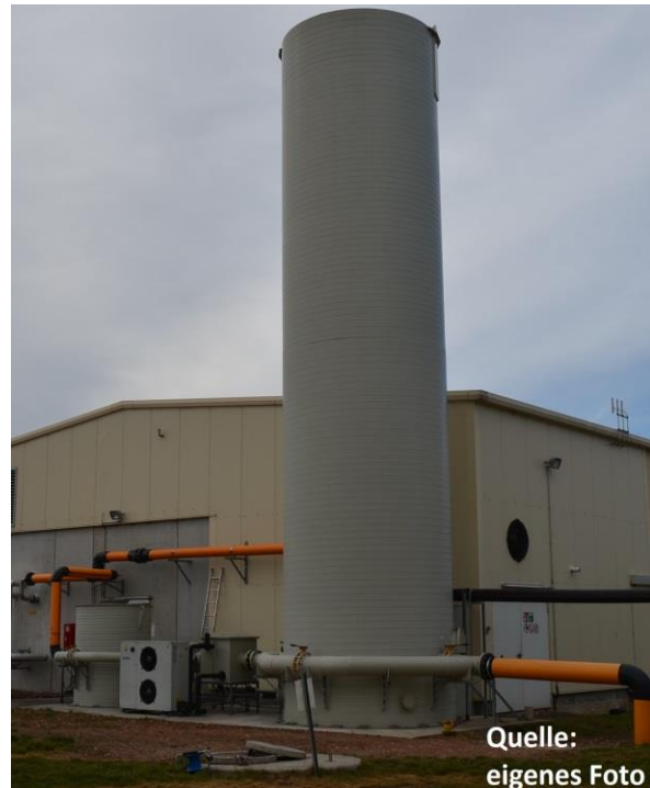
Bild 8: Entschwefelungskolonne mit nachgeschaltetem Aktivkohlefilter
