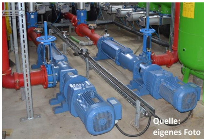
Bild 14: Exzentrerschneckenpumpe für Substratzufuhr (rechts) und Abfuhr (links)
