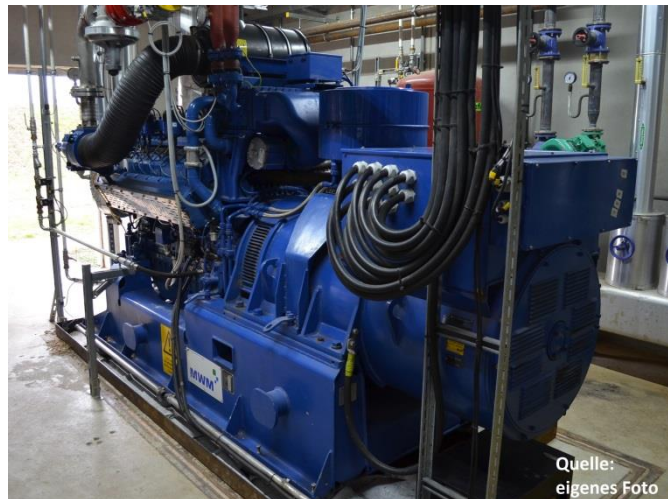
Bild 10: Blockheizkraftwerk vom Typ MWM
