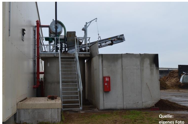
Bild 12: Separator mit Presswasserbehälter und Silowand Quelle: eigenes Foto
