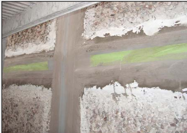
Horizontal verlaufendes Fugenband mit 5 cm Klebeband überklebt.
