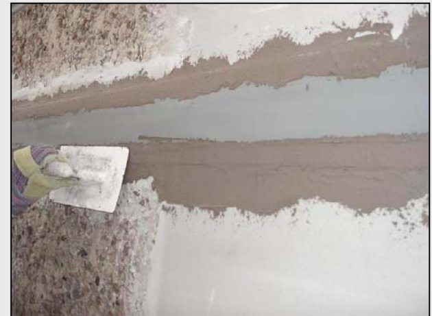
Verklebung des Fugenbandes mit Flexyl
