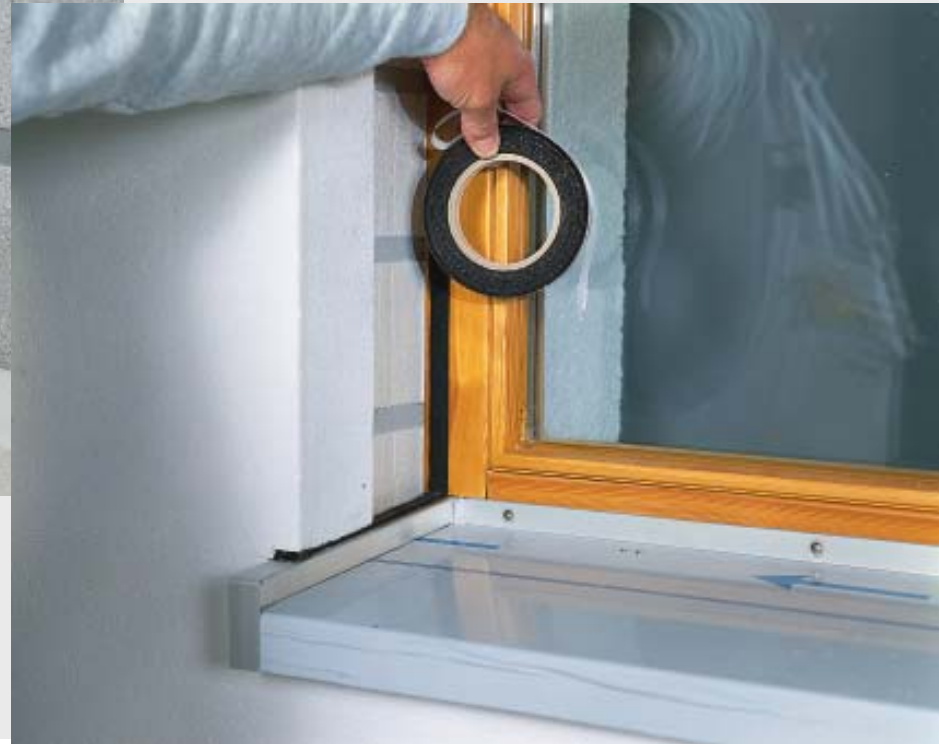
Anschluss an die Fensterlaibung
