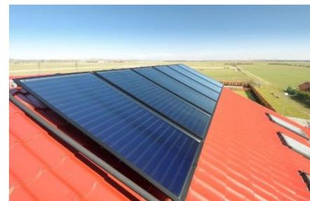
Die zwei großen Vorteile bei Flachkollektoren sind die geringen Herstellungskosten und die Möglichkeit neben einer Aufdachmontage auch eine Indachmontage zu realisieren
