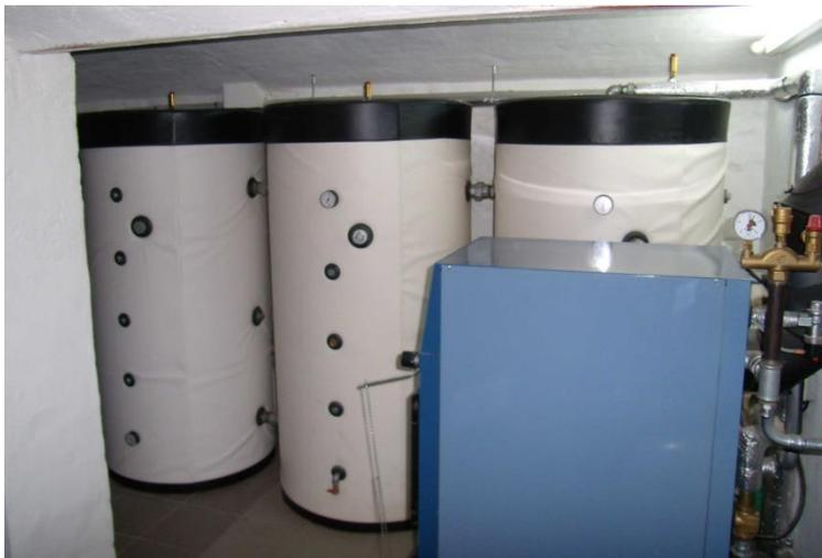
Abbildung 94: Drei in Reihe installierte Wärmespeicher
