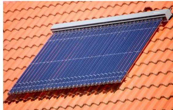
Abbildung 13: Vakuumröhrenkollektor fertig montiert
