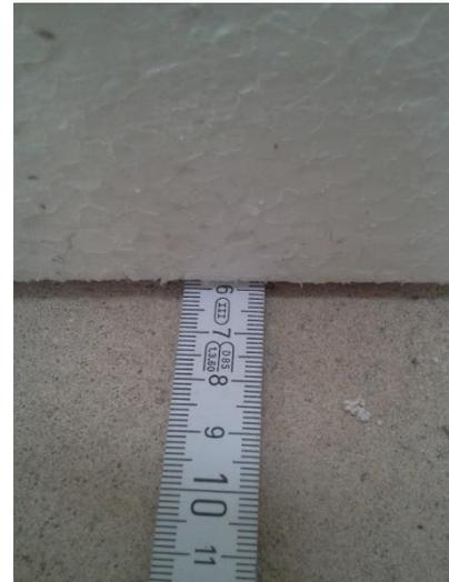
Abbildung 33: aktuelle Dämmdicke der Kellerdecke
