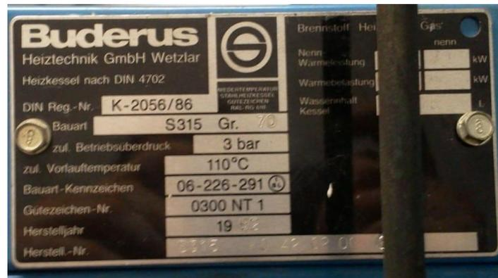
**Abbildung 100: Typenschild des Heizölkessels**
