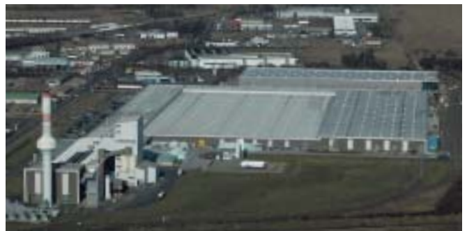
Floatglaswerk Euroglas Haldensleben/Deutschland
