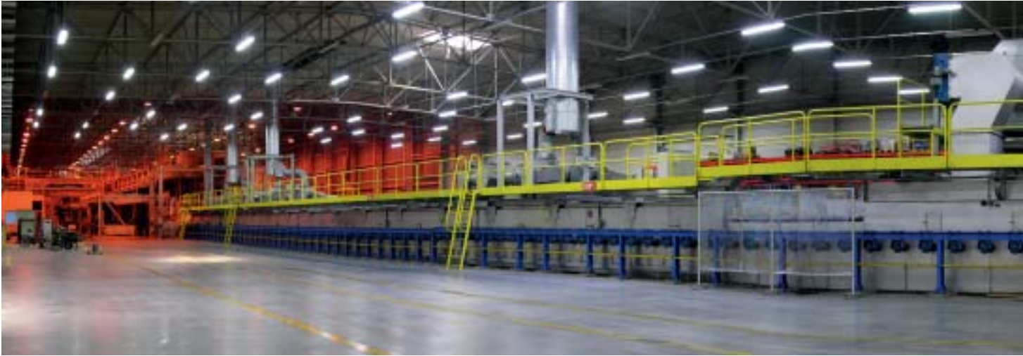
Beeindruckende Ausmaße: Die Gesamtlänge der Floatglas-Anlage beträgt mehrere hundert Meter.
