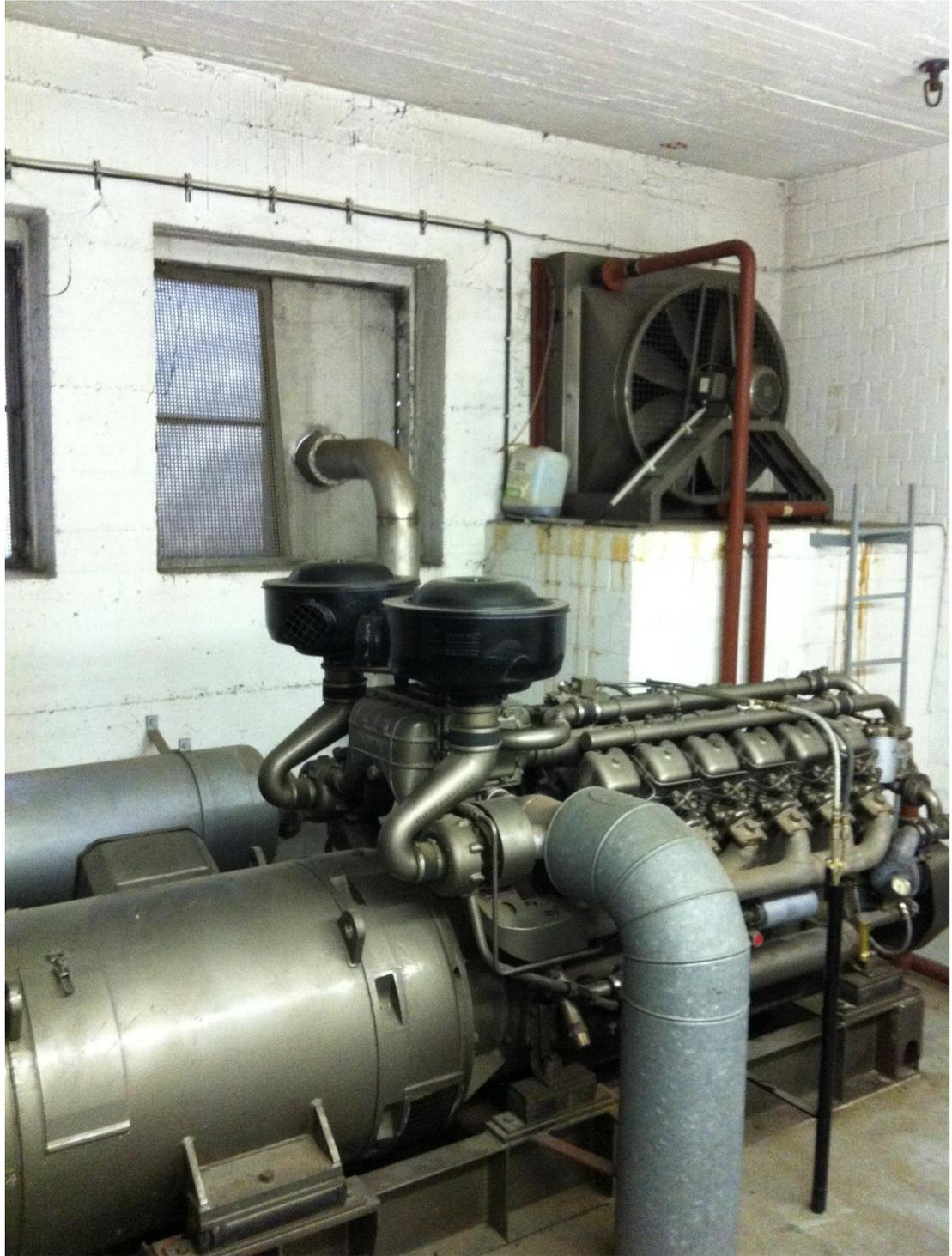
**Abbildung 2-2:** Vorhandene Netzersatzanlage (Dieselaggregat)
