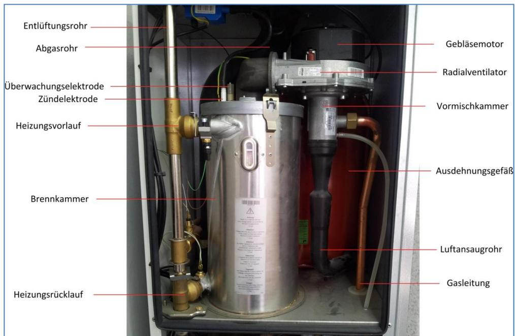
Abb. 18: Brennwertkessel CGW 20/120
