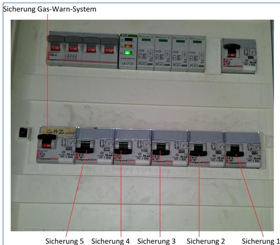
Abb. 25: Sicherungskasten
