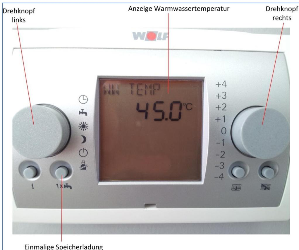
Abb. 29: Bedienmodul Einstellung Warmwassertemperatur
