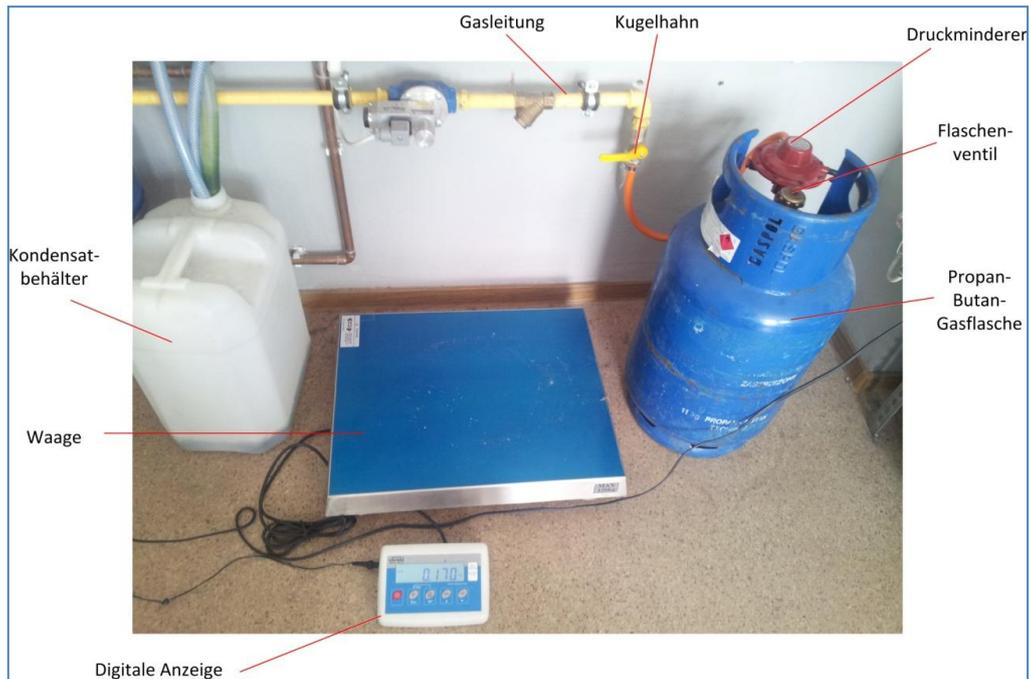
Abb. 27: Waage und Gasflasche
