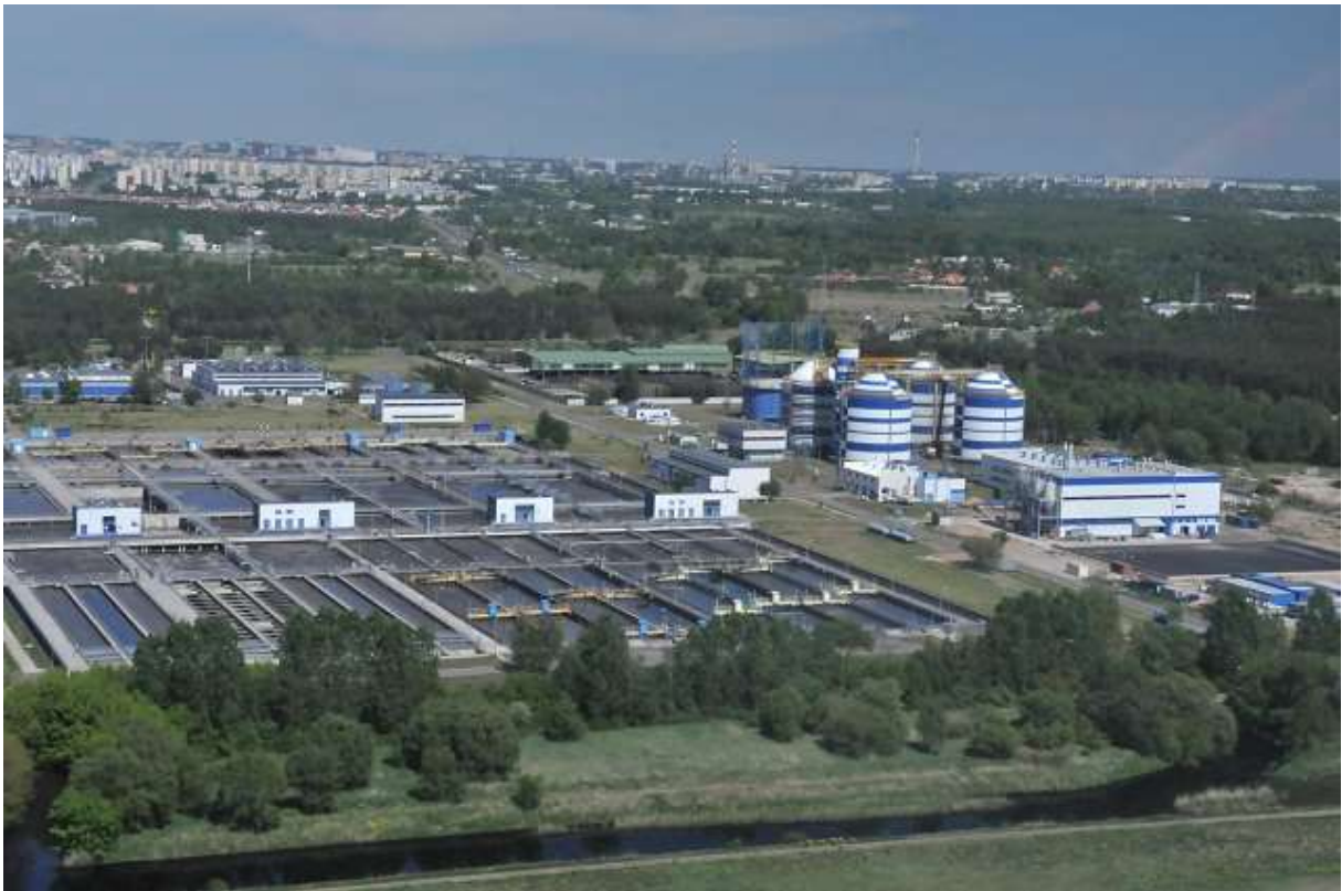
Abbildung 1: Übersicht der Kläranlage (Mai 2009) /11/
