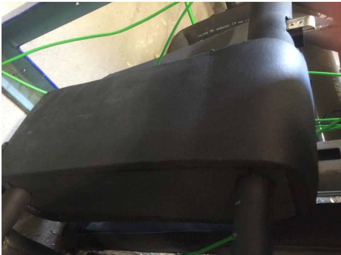
Abbildung 5.8: Solevorwärmer
