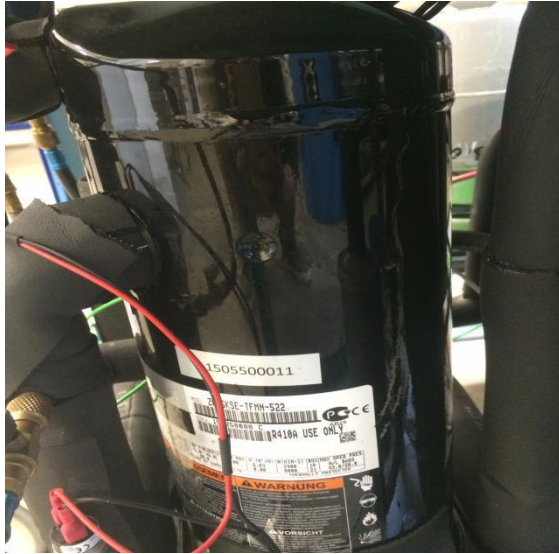
Abbildung 5.15: Scroll Kompressor Scroll
