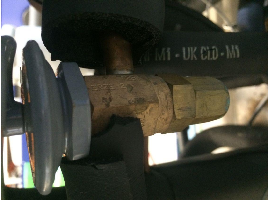
Abbildung 5.4: Expansionsventil
