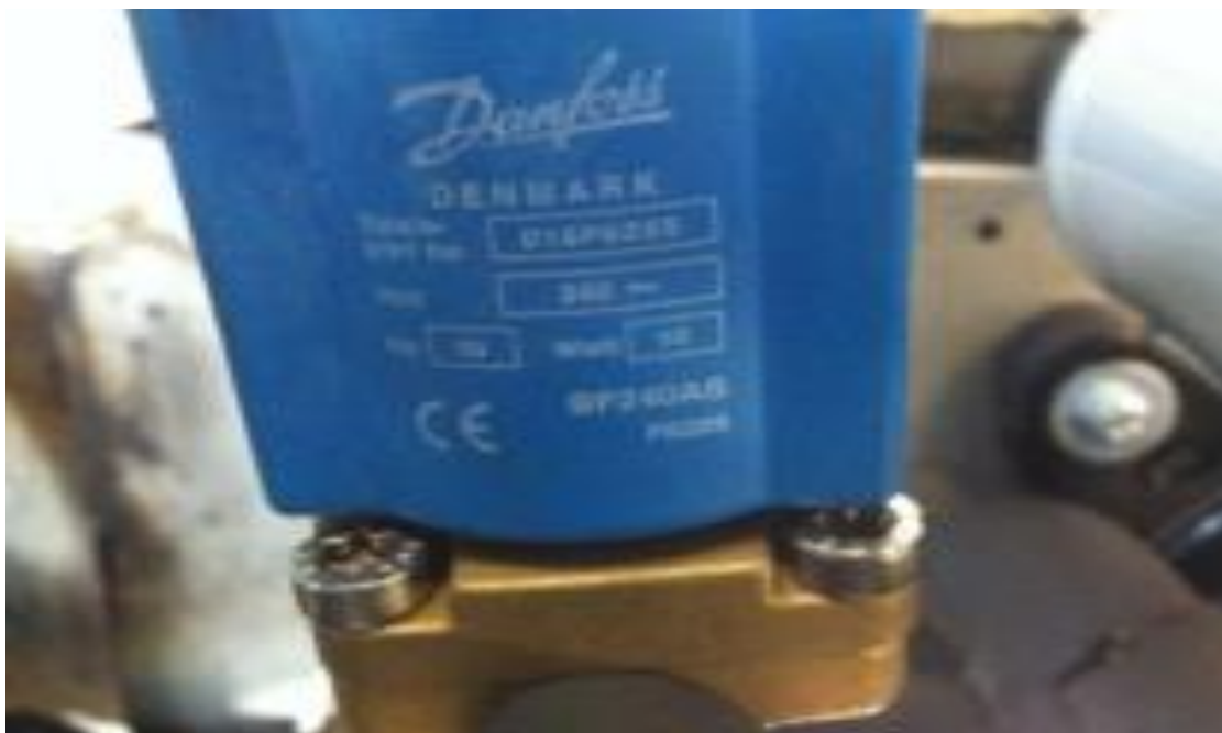
Abbildung 5.6: Magnetventil
