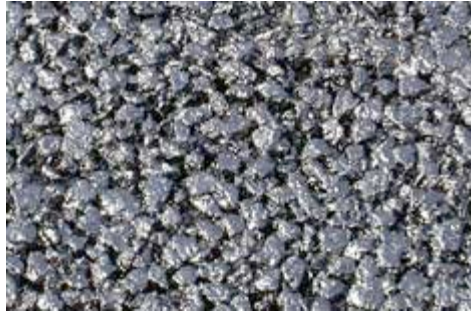
Abb. 2.2: Fahrbahnoberfläche aus offenporigem Asphalt
