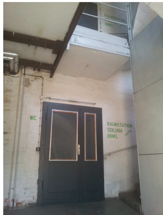
Treppenhaus (Haus K)
