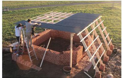
Durch das geringe Gewicht und den erschwinglichen Preis, ist Wellblech eine gute Alternative zu teuren Dachziegeln.
