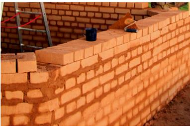
Getrocknete Lehmbausteine bilden mit Lehmmörtel nach dem Abbinden eine homogene Einheit.
