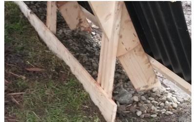
Der Fußpunkt der Fassade wird durch Latten vertikal verstärkt.
