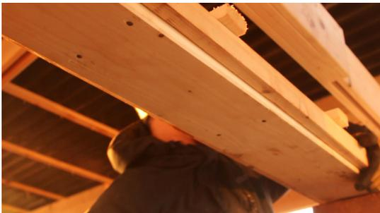
Bevor die letzten Steinreihen gelegt werden, wird der Ringanker eingebaut und der Türsturz befestigt.
