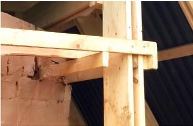
Die Verbindung vom U-Rahmen mit dem Ringanker ist ein gutes Beispiel für den Einsatz von Schnittholz und Latten.
