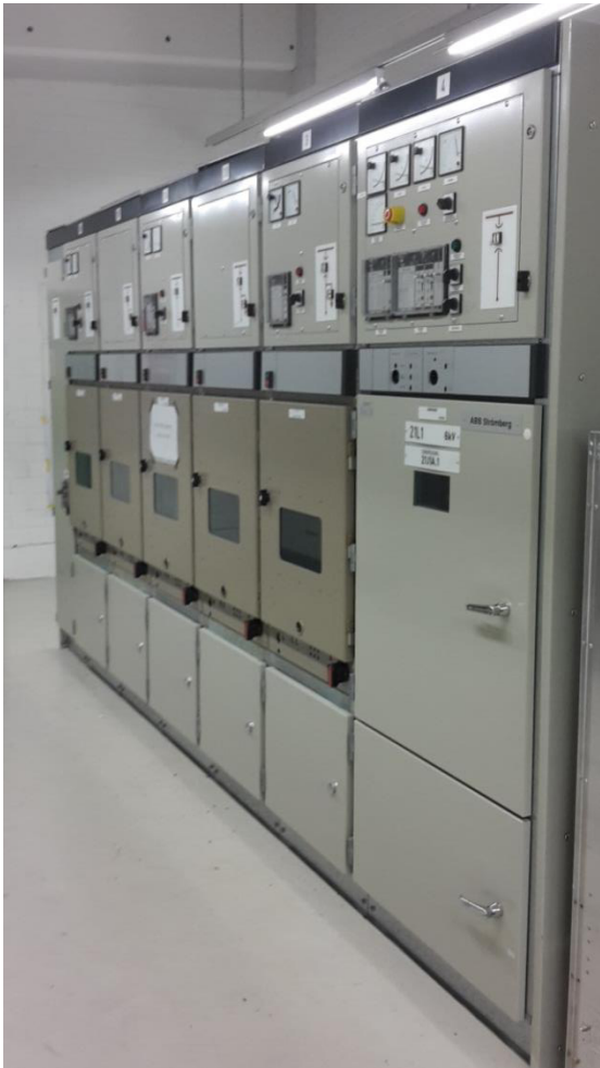
Abbildung 22: 6-kV-Mittelspannungsverteilung
