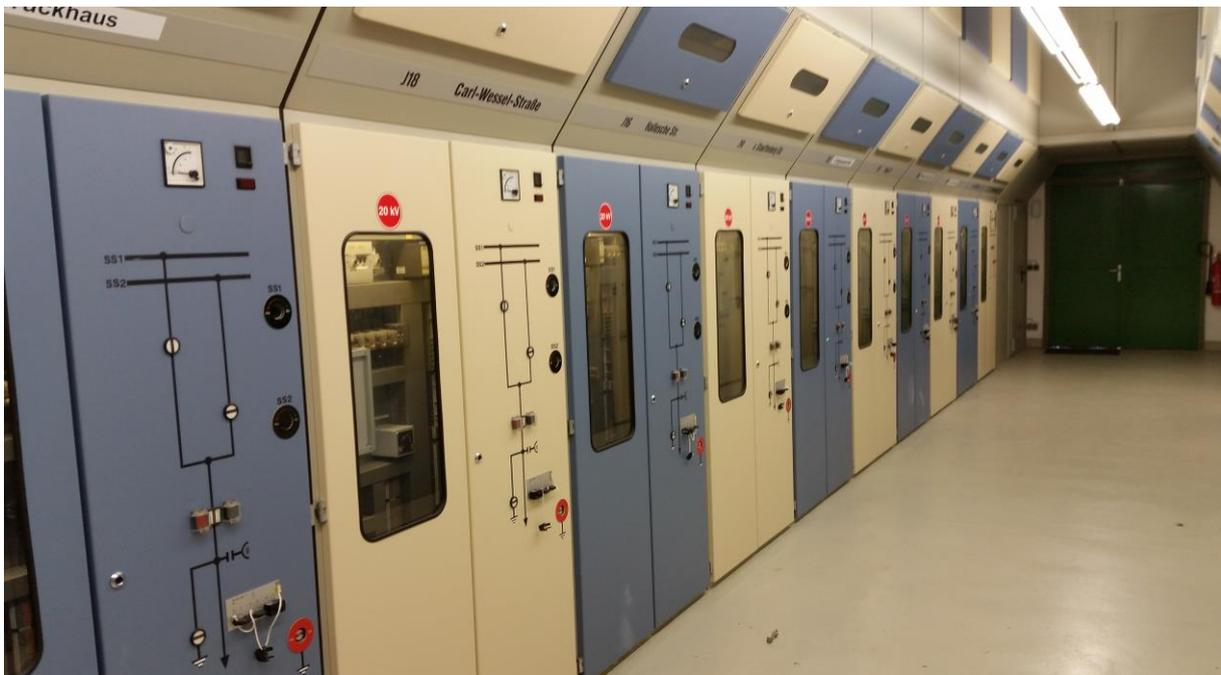
Abbildung 3.1: luftisolierte Zellen im UW Süd
