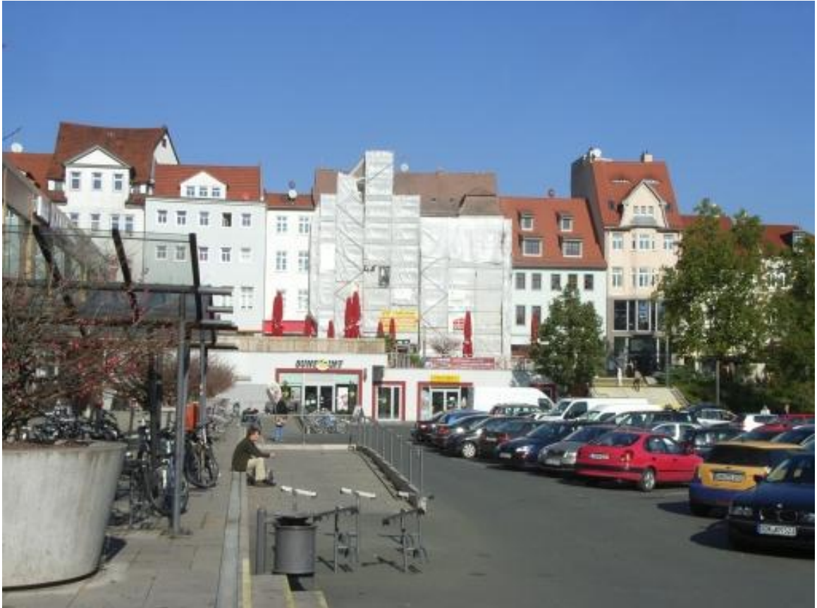
Eichplatz, Sanierung einiger Häuser, 2011
