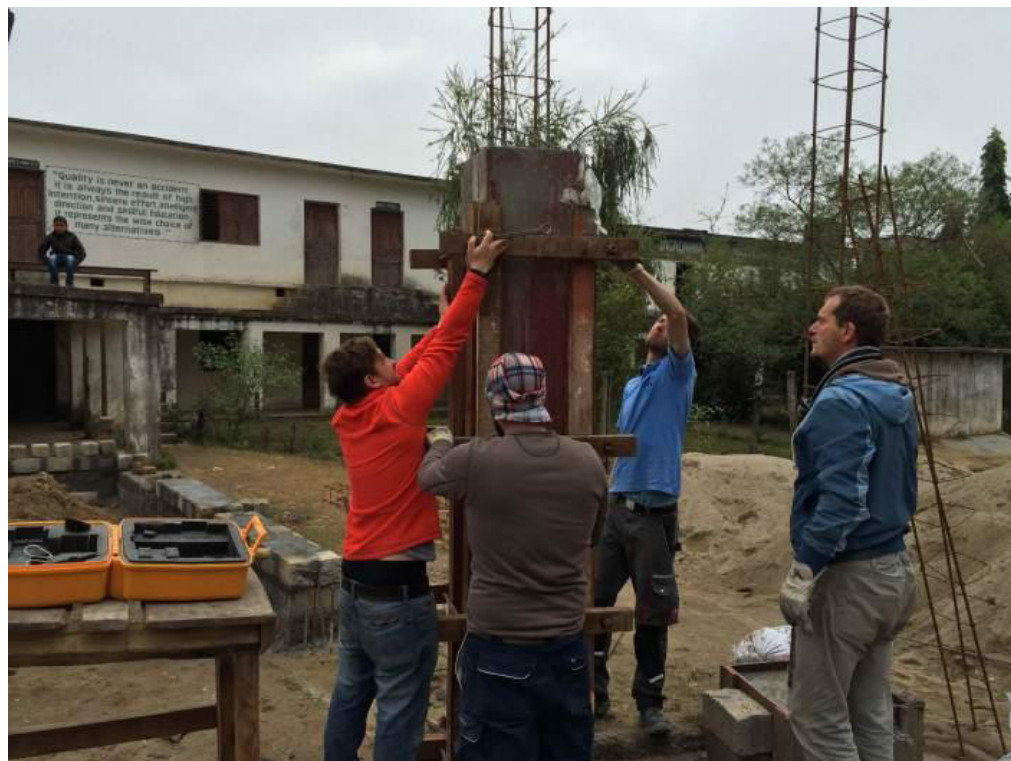
Abbildung 21: Ausschalen von Stützen
