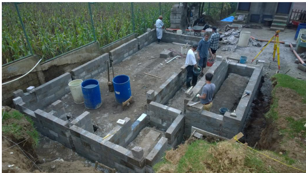
Abbildung 17: Errichtung des Speichergebäudes
