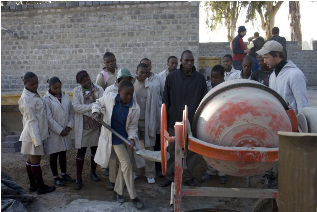
Abbildung 8: Gemeinsames Arbeiten auf der Baustelle
