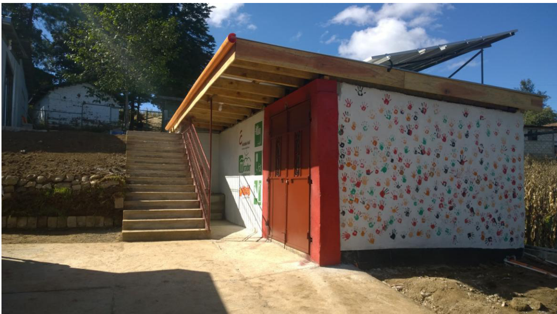
Abbildung 14: Gebäude zur Speicherung von Regenwasser und Sonnenenergie
