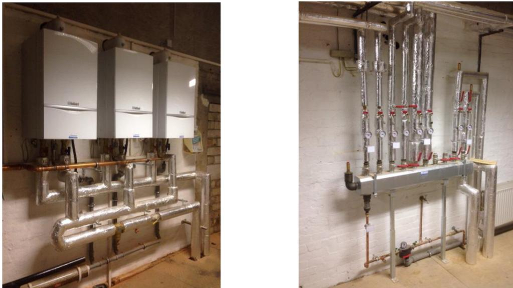
Abb.39: rechts: Isolierte Heizrohre im Heizraum, links: Vaillant Kaskadenheizung
