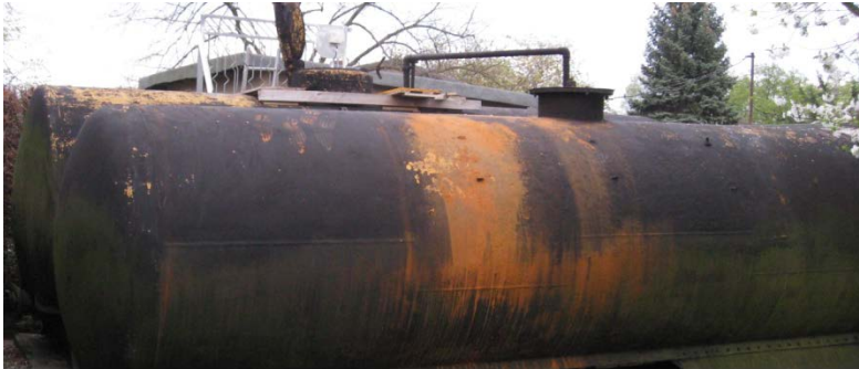
Abbildung 3.1: Darstellung Wasserspeicher im Außenbereich
