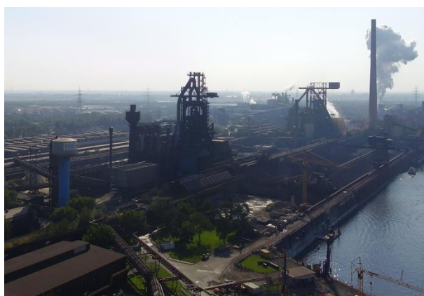
Abbildung 14: Exemplarische Ansicht eines Gaskraftwerkes 82
