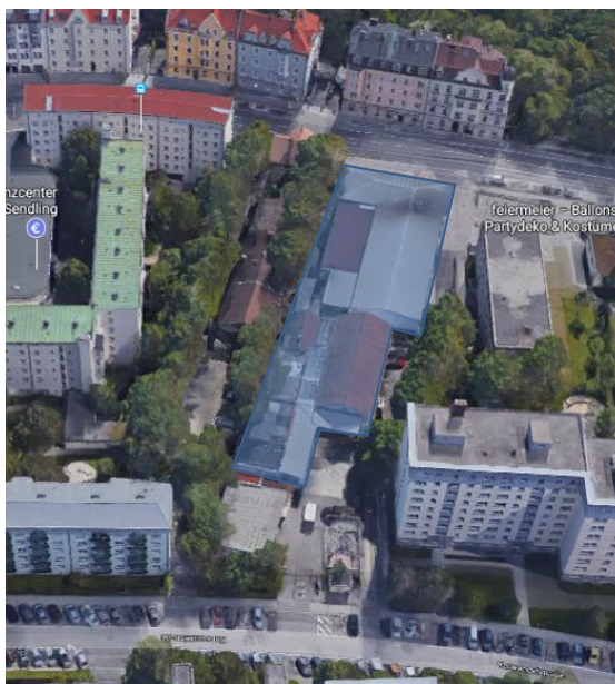
Abbildung 9: Exemplarische Ansicht einer handwerklichen Produktionsimmobilie 55
