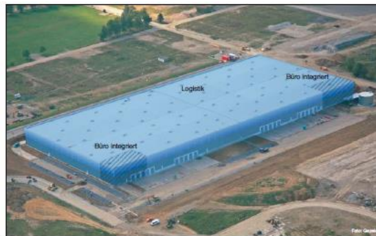
Abbildung 16: Exemplarische Ansicht einer modernen Lager- und Logistikimmobilie 88
