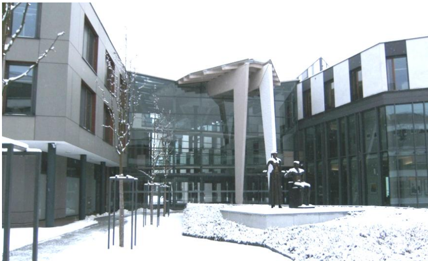
Abbildung 43 Frontansicht eines Teils des Gebäudeensembles Paul-Wunderlich-Haus, Eberswalde (Foto: Schakib-Ekbatan)
