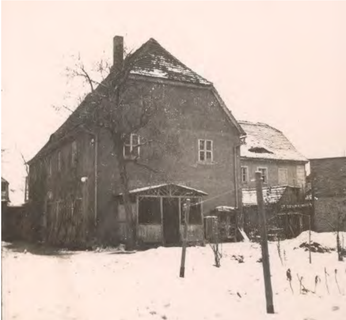
1949. Pfarrhaus Zöschen, 1985 abgerissen. (Thorsten Fielon #6.04)
