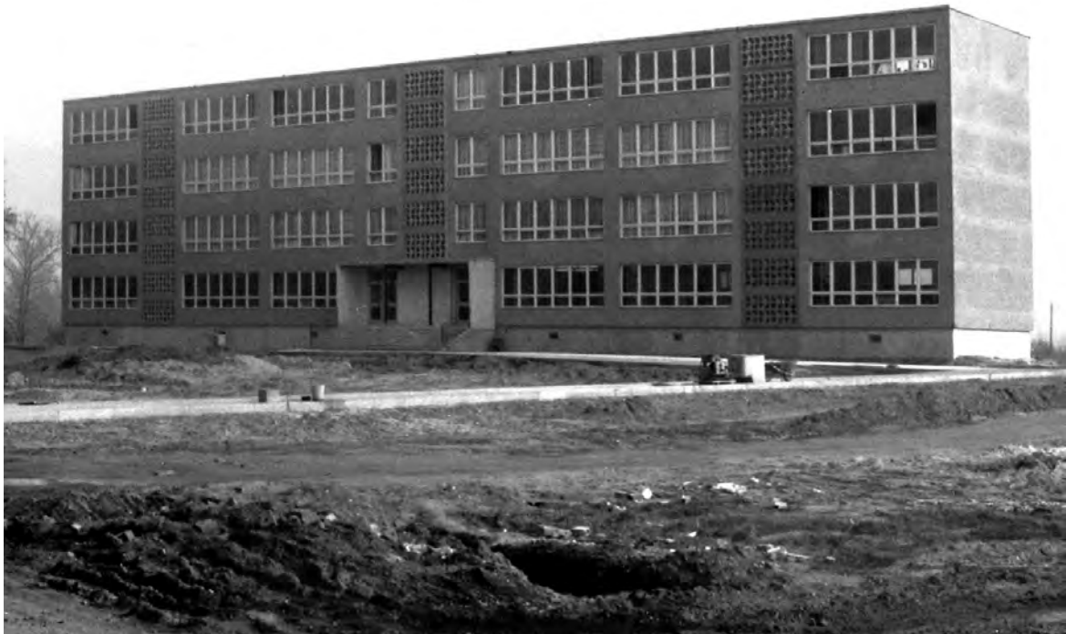
1978. Schulneubau. (Bildbearbeitung Jörg Mantzsch, Christa Pfohl #3.04)
