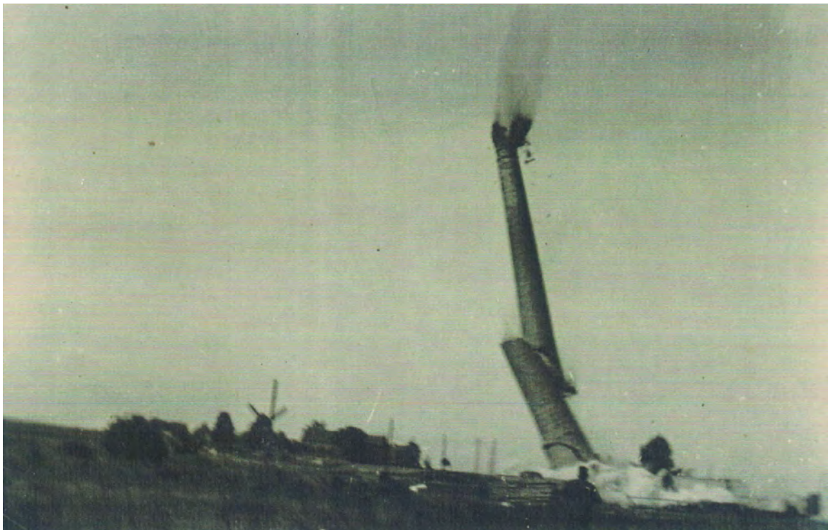
1935. Großer Schornstein der Schamotte-Fabrik. Abriss. (Anja Klaus #5.07)
