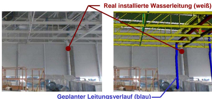
Abbildung 4-13: Positionsabweichung: modellierte Wasserleitung (re) versetzt installiert [eigene Aufnahme]
