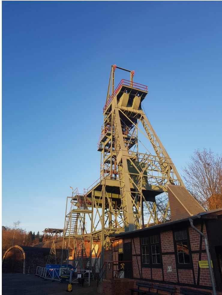
Abb. 1: Das älteste noch in Deutschland betriebene Stahlfördergerüst des Röhrgeschachts in Wettelrode bei Sangerhausen.
