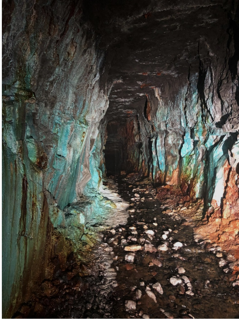
Abb. 3: Grünes Gewölbe im Querschlag von der Tiefbaushole zum Segen-Gottes-Stollen. Die Farbgebung der Stollenwände resultiert von Ausfällungen diverser Kupferhydrogenkarbonate und -salze.
