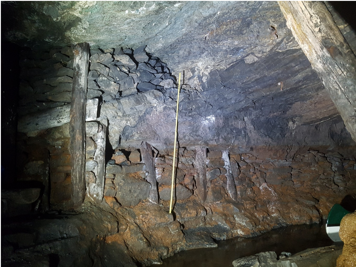
Abb. 17: Blindüberschiebung am Ende der Rampen- und Duplexstruktur (Aufschluss 1). Die ehemaligen Flöze sind abgebaut und durch den Verbau mit Abraum gut nachzuvollziehen. Im weiteren Verlauf des Stollens in Richtung Westen (Kanu, rechts unten) ist das Normalprofil zu beobachten.
