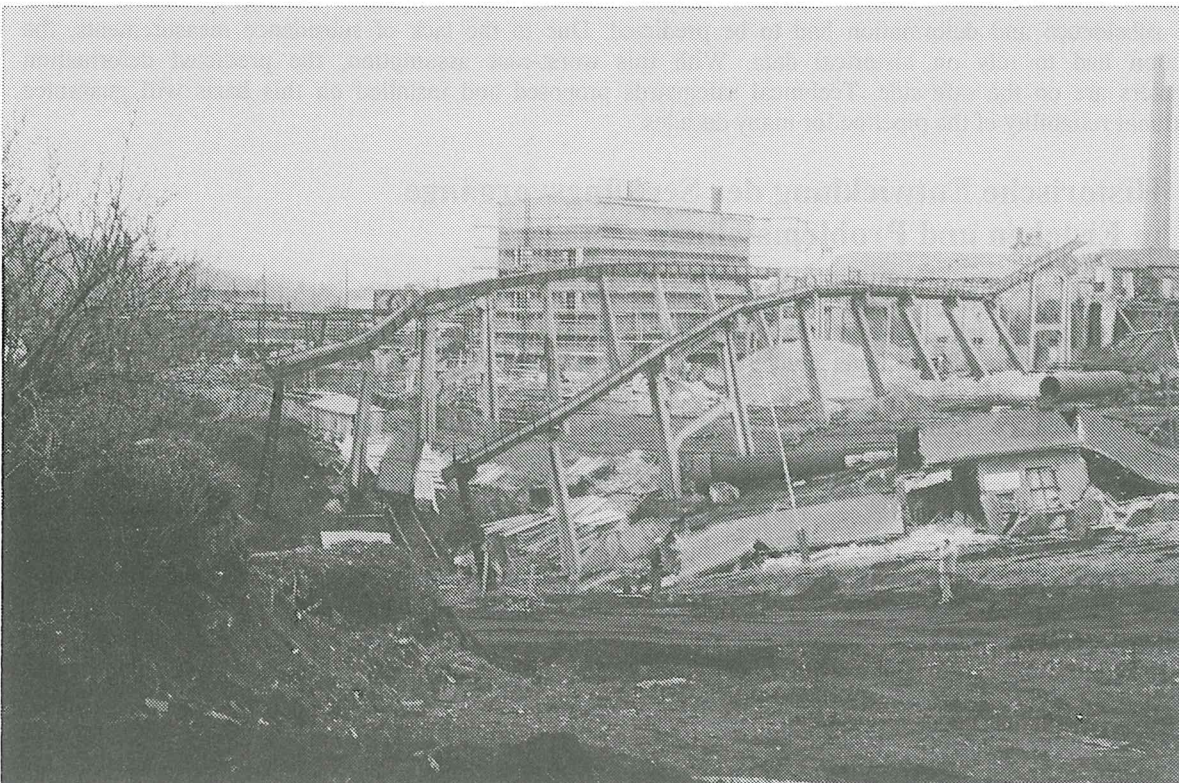
Abb. 1: Zerstörungen im Gelände der Karl-Liebkecht-Hütte 1976. (Foto: SUDERLAU)
