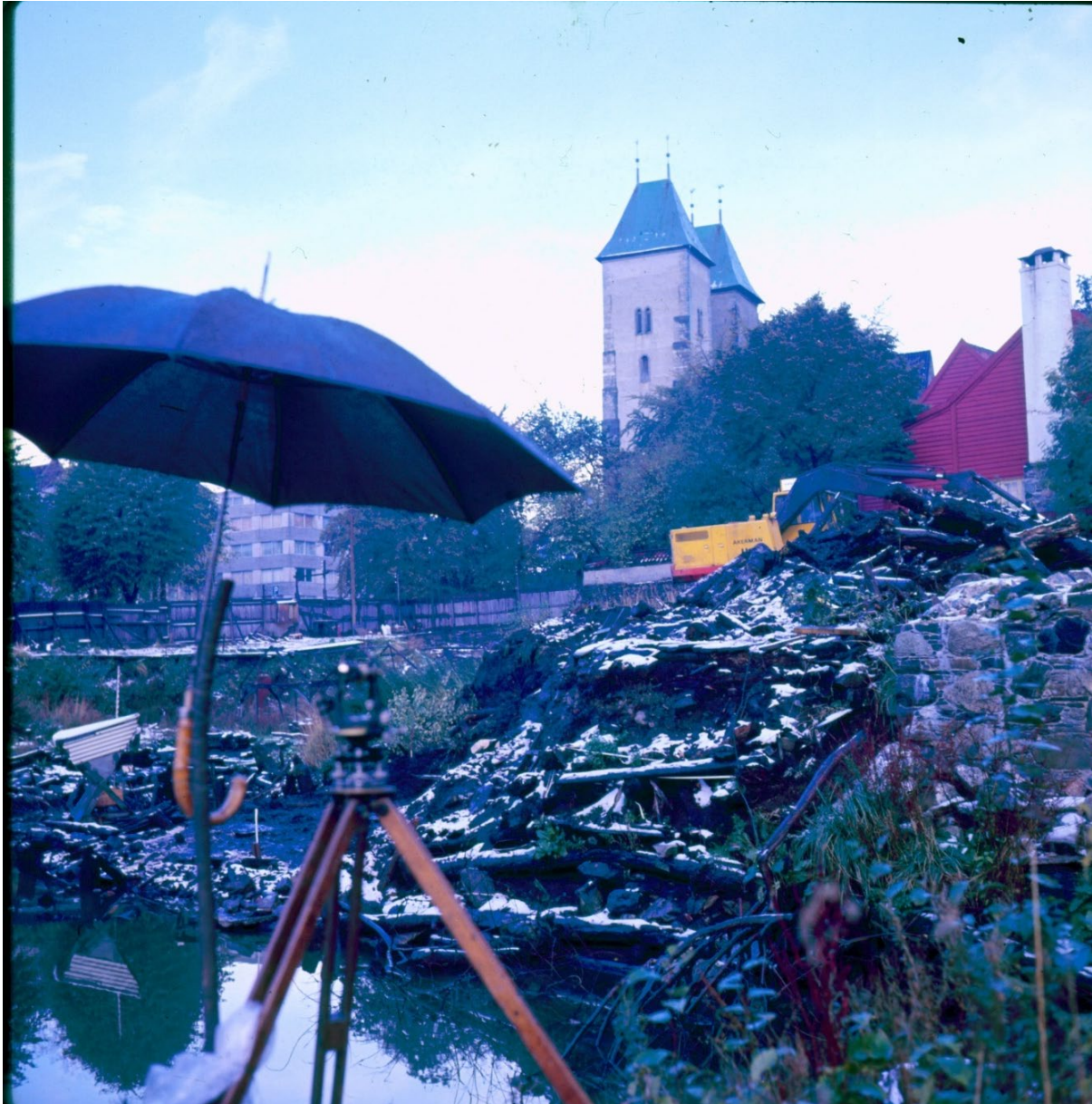
Abbildung 168: Übersichtsbild von den Bryggen Ausgrabungen. Zu erkennen sind Reste des mit dem Bagger abgeräumten Brandschutts der 1955 abgebrannten Bebauung des 18. Jahrhunderts und die Mariakirche im Hintergrund. Foto: Archiv der Universität Bergen
