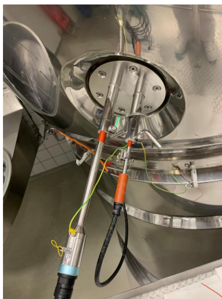
Abb. 4: Befestigung zweier Sonden (links: Raman, rechts: NIR) mittels Flansch am WSG (In-Line Messung)
