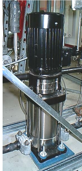
Abbildung A 2: 11-stufige Kreiselpumpe CRN 2-110 – Fa. GRUNDFOS Maße: Grundfläche: 15 x 21 cm \varnothing Pumpenkörper: 14 cm Gesamthöhe: 61,5 cm
