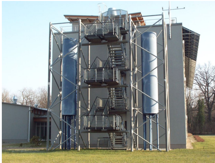
Abbildung 21: Warmwasserspeicher vor der Westseite des Gebäudes
