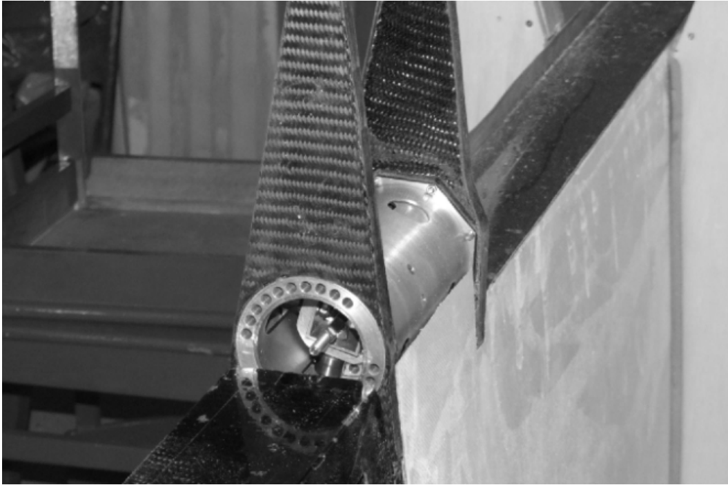
Bild B.13: Einbau des Kurvengerätes
